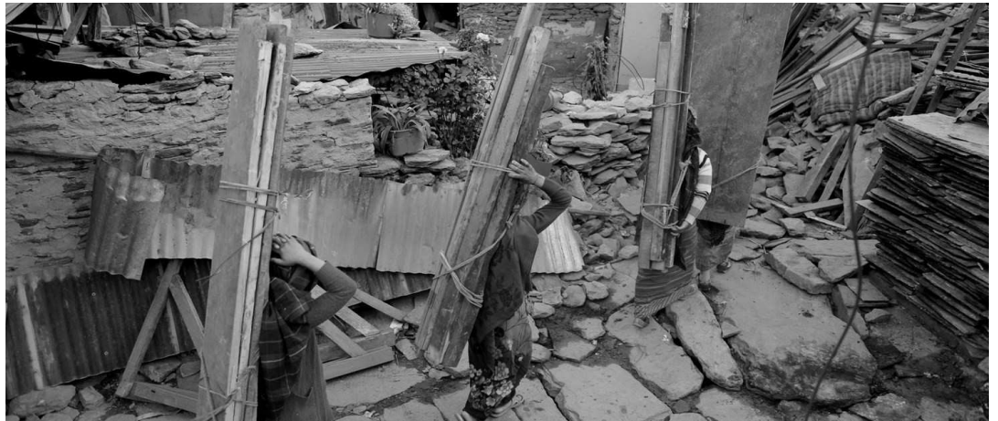
Aufräumarbeiten nach dem Erdbeben
