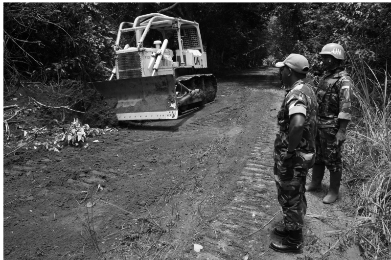
UN-Blauhelmsoldaten beim Bau einer Straße im Jahr 2010.
