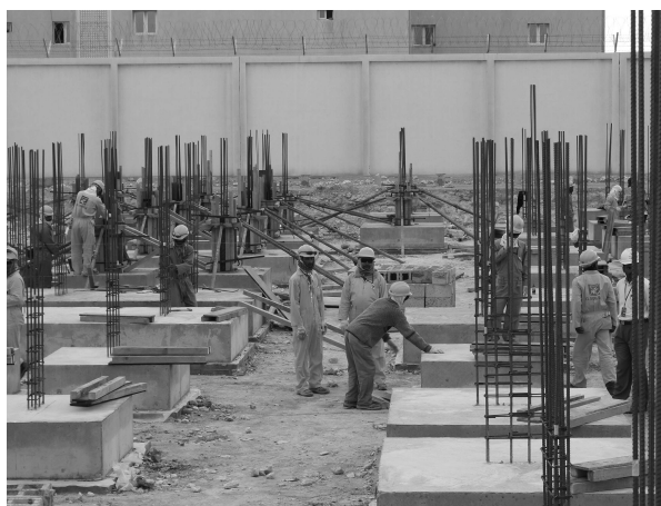
Arbeitsmigranten auf einer Baustelle in Doha
